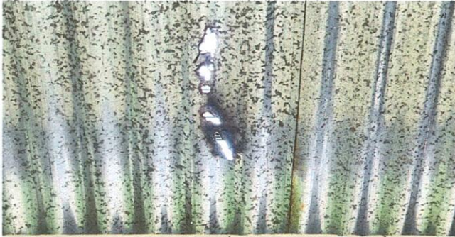
Foto1: Mejoramiento de techo por deterioro
