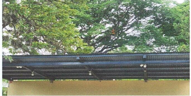
Foto 2: Ampliación de cubierta de lámina.
